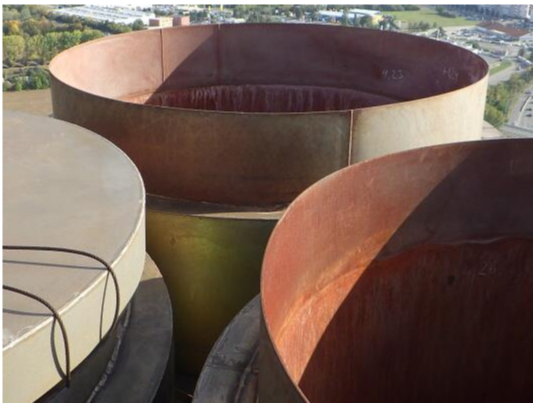
Obr. 36: Horní hrana ochranné vložky č.3 v hlavě komína v +125,000m je bez závad.
