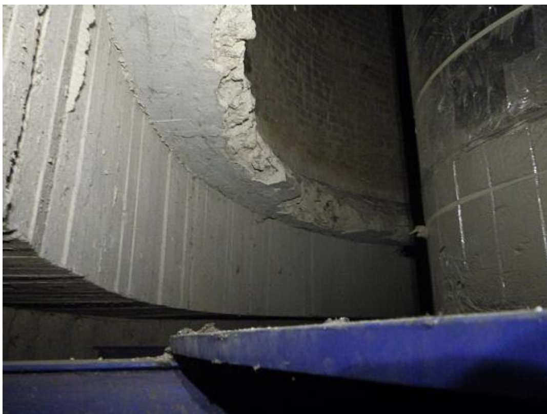
Obr. 48: Stavebně neupravená horní hrana původní výsypky nad nosnou ocelovou deskou s ochrannými vložkami v +4,200m.
