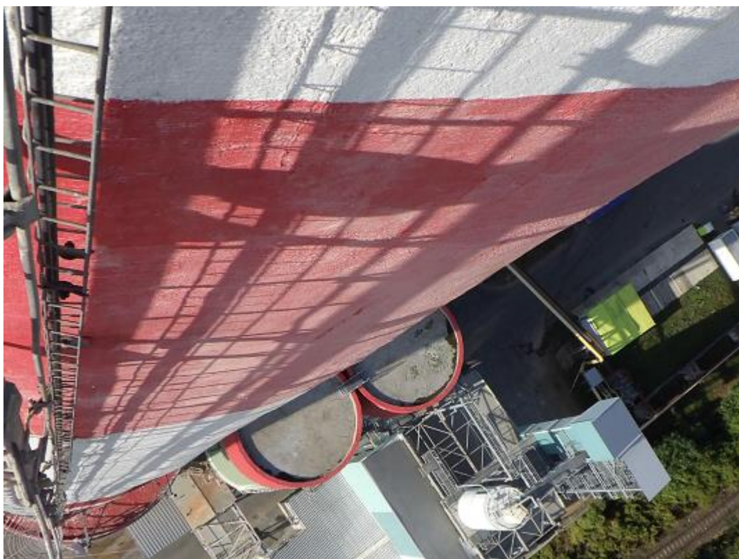
Obr. 17: Plošně vymytý (vybledlý), popř. znečištěný provozními úsadami nátěr DLZ od +105,000m na J straně komína.
