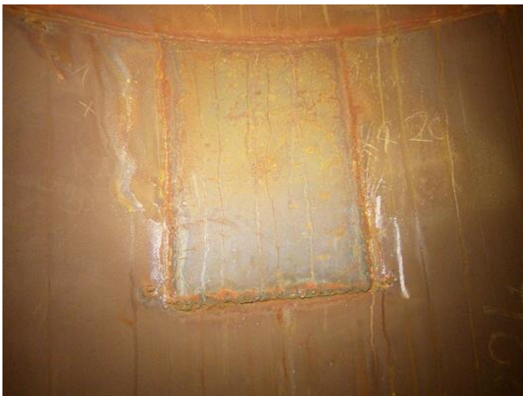
Obr. 32: Stav ocelové záplaty ochranné vložky č.2 z r.2022 v cca +34,000m.
