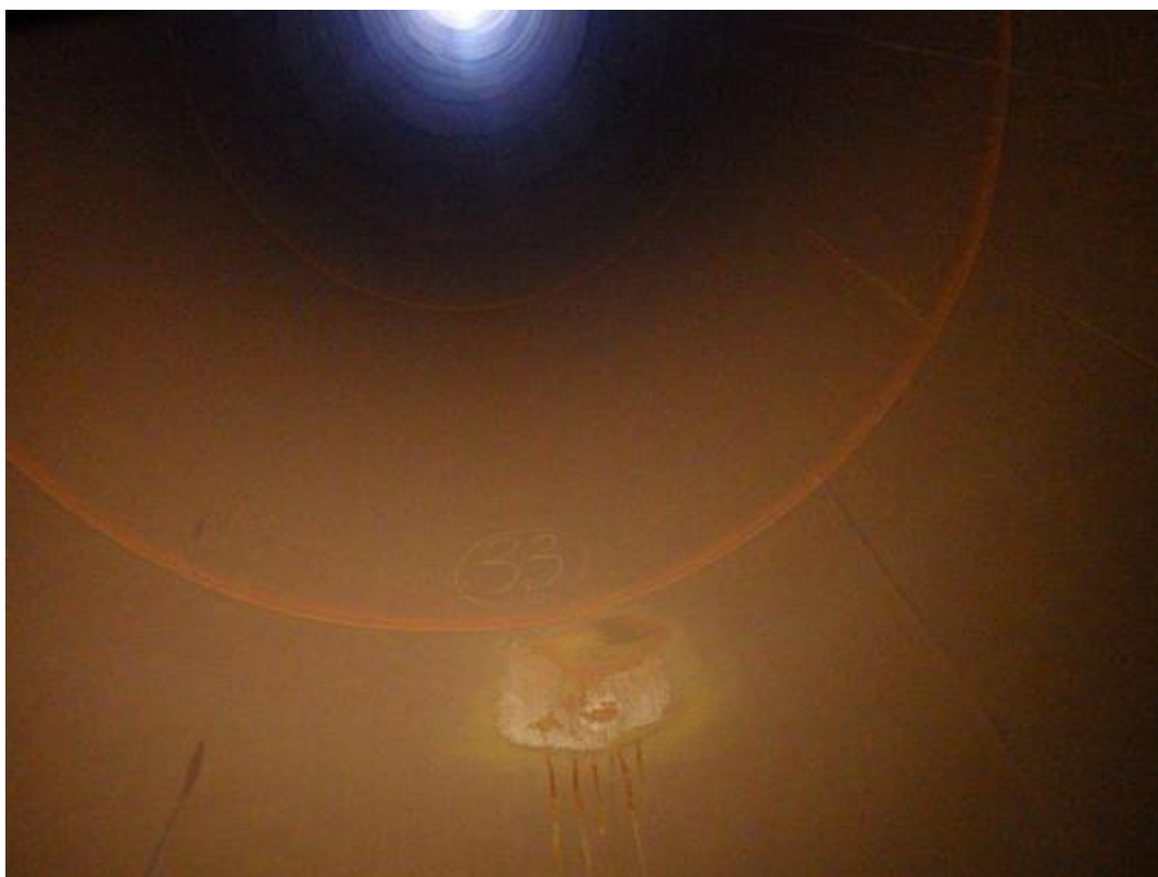
Obr. 34: Lokální poškození vnitřního povrchu vložky č.2 v cca +34,000m, vlivem svarů na vnějším povrchu. V budoucnu zde může dojít k proděravění!
