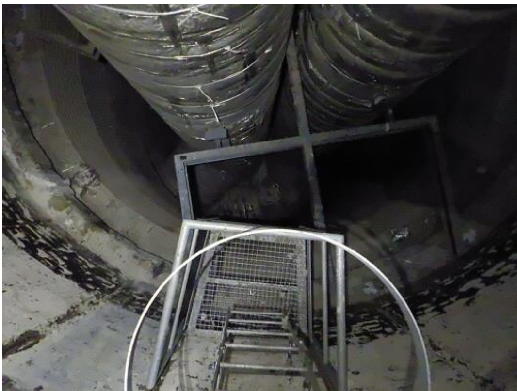
Obr. 52: Celkový pohled plošinu v +21,200m a na stabilizační konstrukci axiální vedení vnitřních ochranných vložek.
