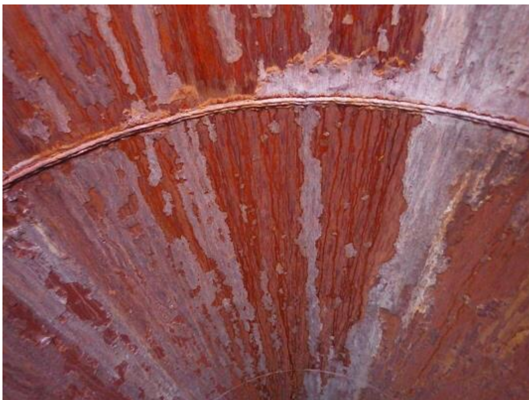
Obr. 38: Detail spoje dílců vnitřní ochranné vložky č.3 v úrovni +112,000m s plošnou korozí a výskytem tenké vrstvy provozních a korozních úsad.
