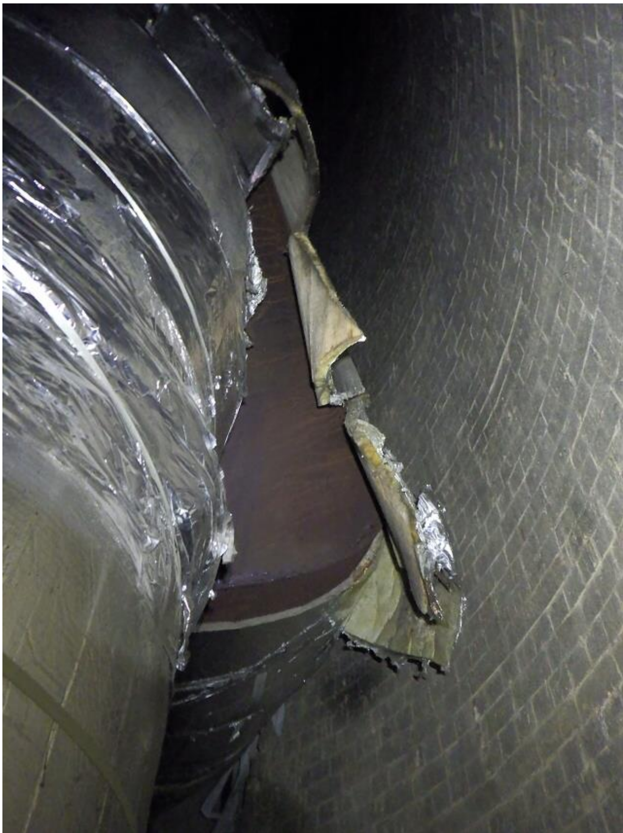
Obr. 50: Rozpadající se tepelná izolace okolo kolene se zaústěním kouřovodu do vnitřní ochranné vložky č.3.
