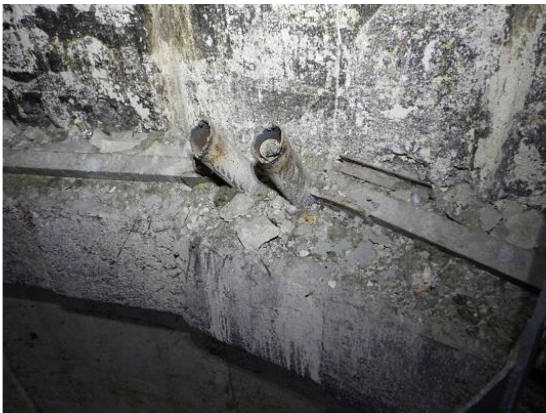
Obr. 54: Nevyužitá ocelová konstrukce na žlb. nosné konzole původního zděného ochranného pouzdra komína v +35,000m.
