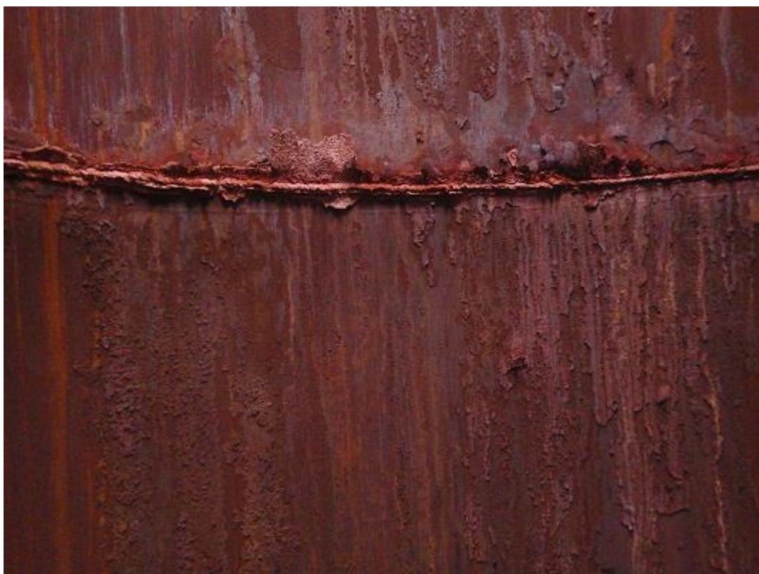
Obr. 28: Detail spoje dílců vnitřní ochranné vložky č.2 v úrovni +110,000m s plošnou korozí a výskytem tenké vrstvy provozních a korozních úsad.
