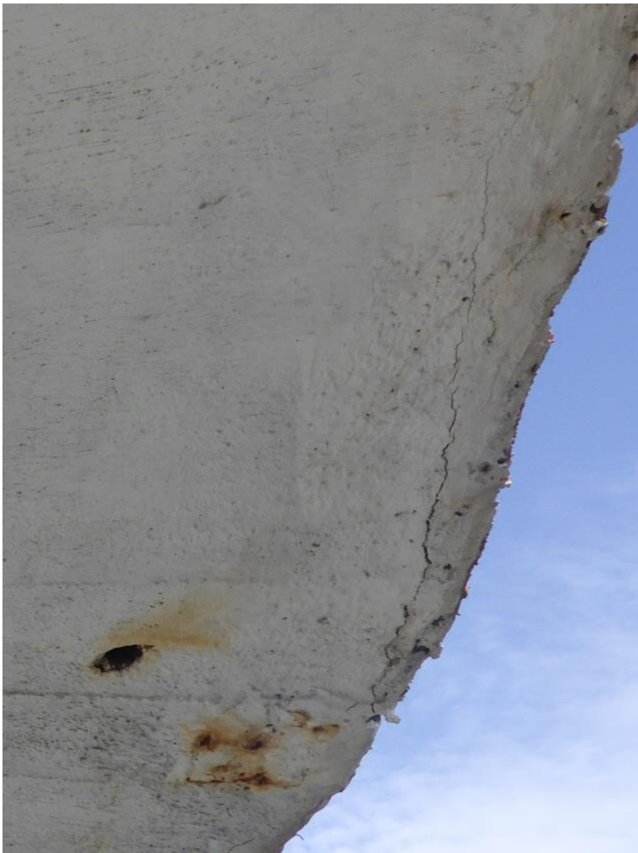
Obr. 19: Souvislá trhlina okolo vnější hrany desky ochozu v +121,000m z pohledu, z JV strany komína.
