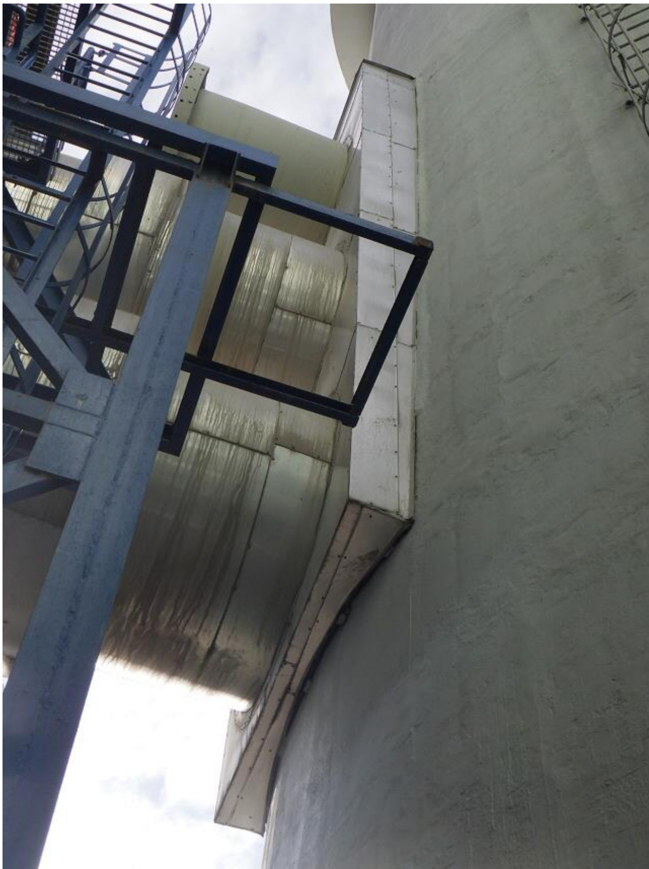
Obr. 3: Celkový pohled na oplechování rámu sopouchu se zaústěnými kouřovody od kotlů K2 a K3.
