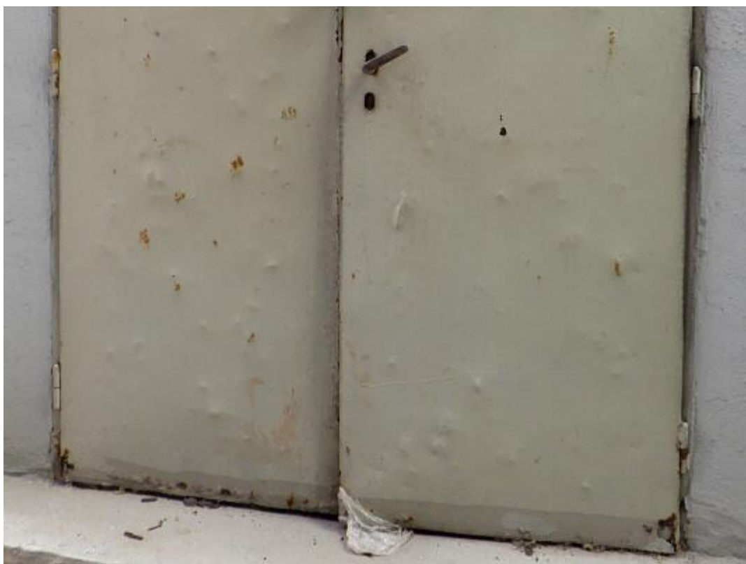
Obr. 1: Lokální deformace, koroze a rozpad plechových vrat v úrovni prahu, u vstupu do komína ze Z strany.
