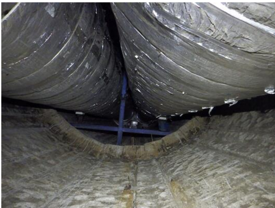
Obr. 58: Celkový pohled na meziprostor komína a na vložky č.1 (vpravo) a č.2 (vlevo) od cca +108,000m. Tepelná izolace obou vložek je bez závad.
