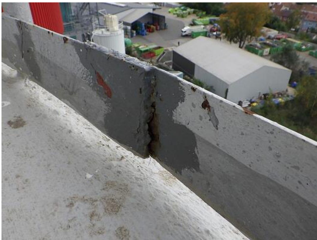
Obr. 7: Lokální koroze svaru okopové lišty zábradlí ochozu v +30,000m.
