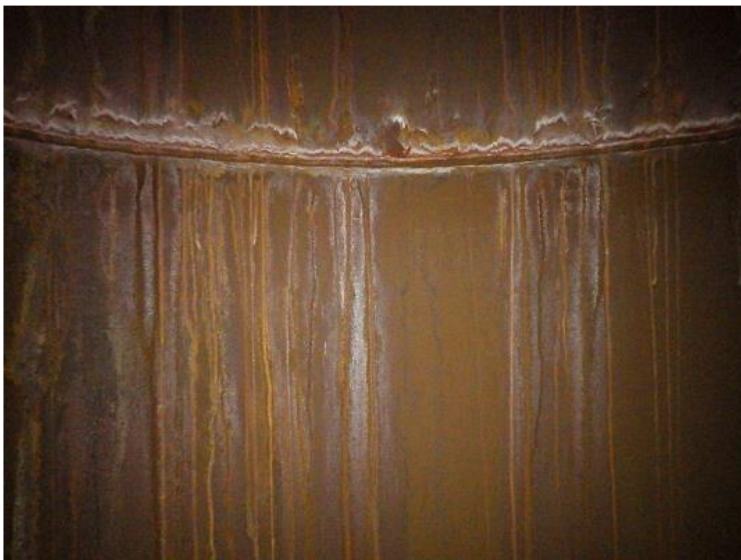
Obr. 39: Detail spoje dílců vnitřní ochranné vložky č.3 v úrovni +96,000m s plošnou korozí a výskytem sraženin kondenzátu.
