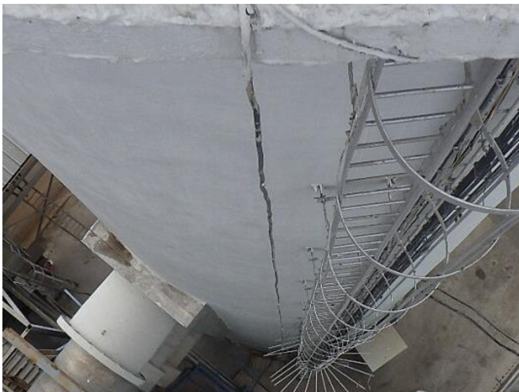
Obr. 5: Volně visící, neukotvený kabel elektroinstalace od ochozu v +30,000m k ÚT ze S strany komína.
