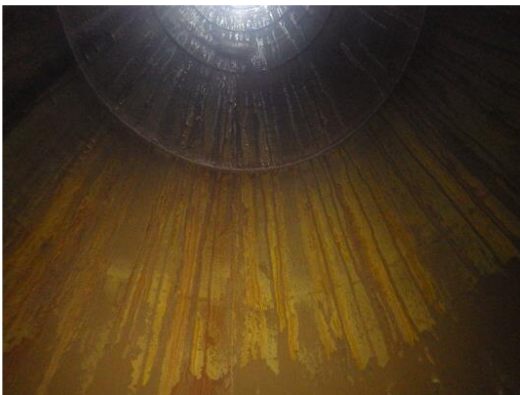
Obr. 41: Vnitřní povrch ochranné vložky č.3 se stopami stékajícího kondenzátu od +69,000m směrem k hlavě.
