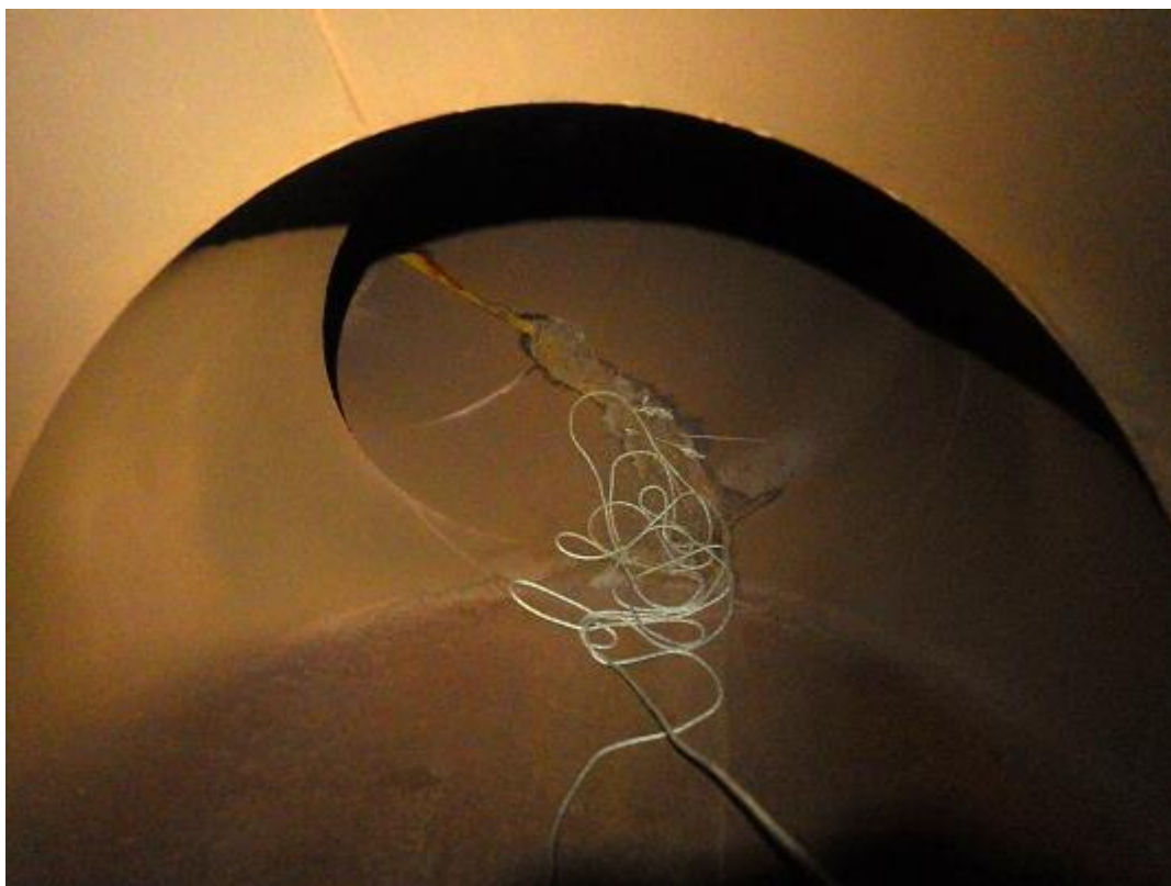
Obr. 45: Dno vnitřní ochranné vložky č.3 se zaústěným kouřovodem.
