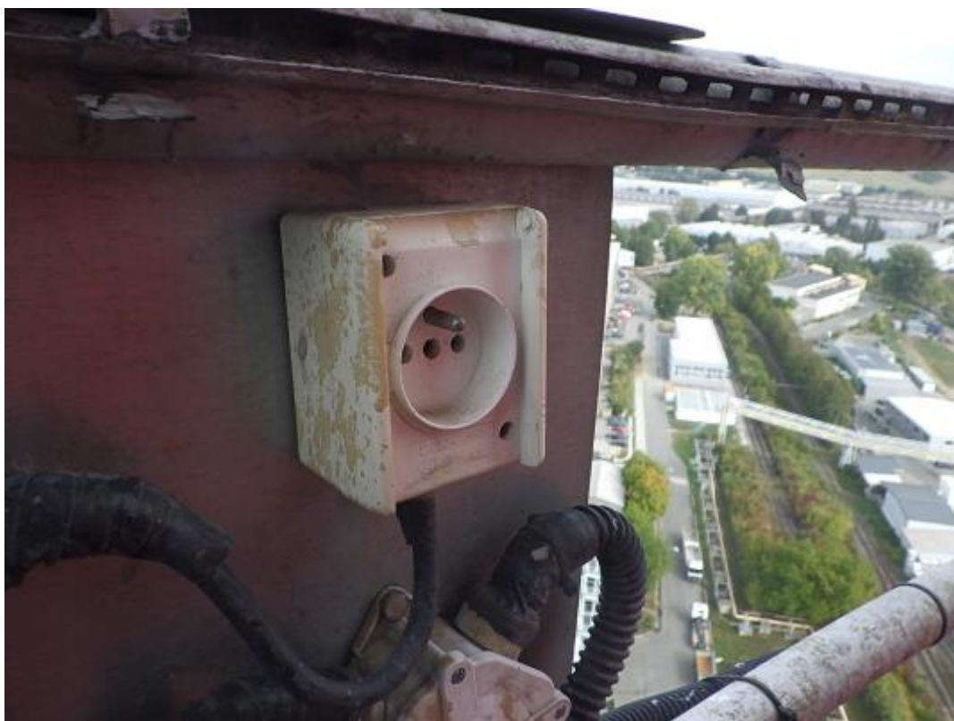
Obr. 14: Chybějící kryt zásuvky u rozvodné krabice elektroinstalace k překážkovým návěstidlům na zábradlí ochozu v +75,000m.
