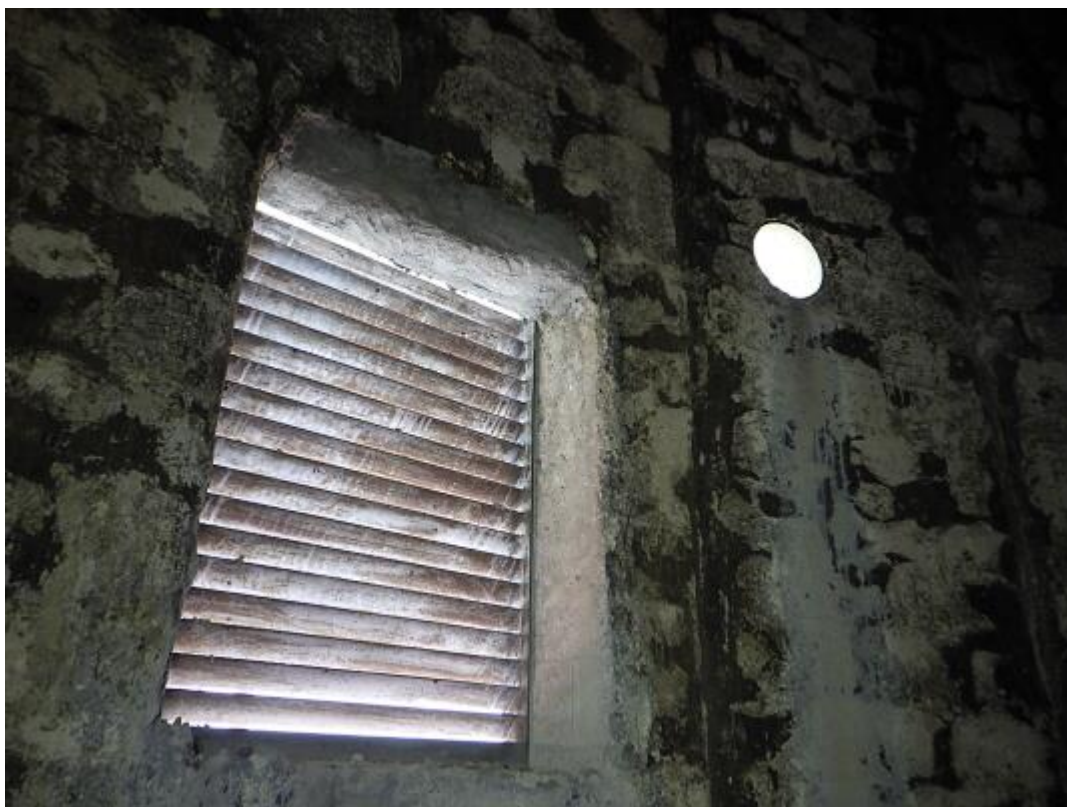
Obr. 56: Větrací otvory v cca +75,000m až +76,000m v dříku komína z meziprostoru.
