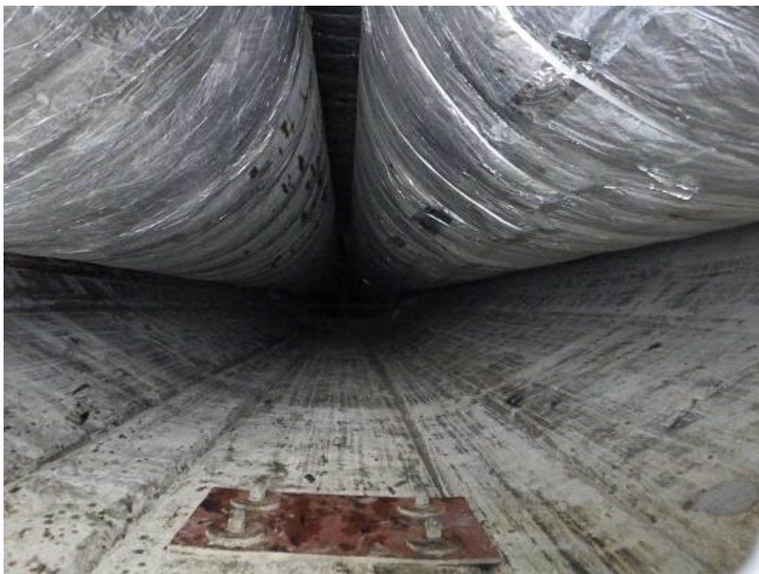
Obr. 59: Celkový pohled na meziprostor komína a na vložky č.3 (vlevo) a č.1 (vpravo) z krytu hlavy komína v +124,000m.
