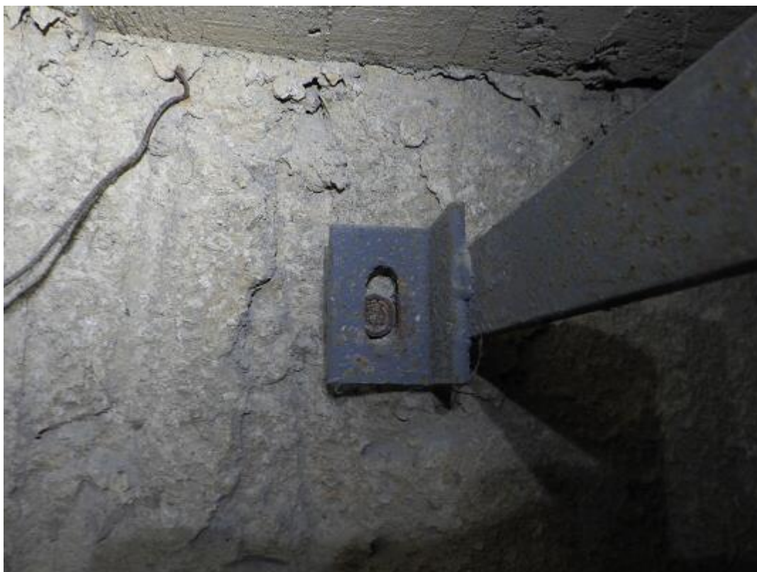
Obr. 47: Nefunkční kotvení žebříku nad původní výsypkou v meziprostoru komína.
