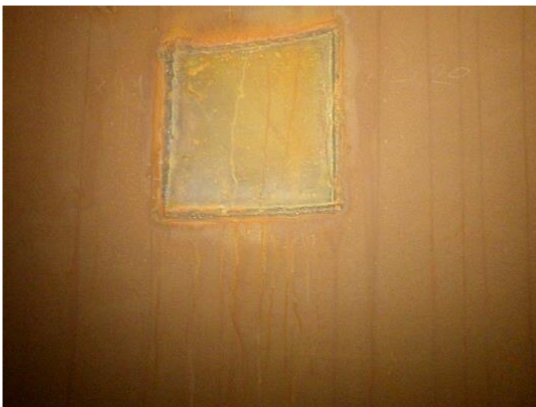
Obr. 35: Stav ocelové záplaty ochranné vložky č.2 z r.2022 v cca +11,000m.
