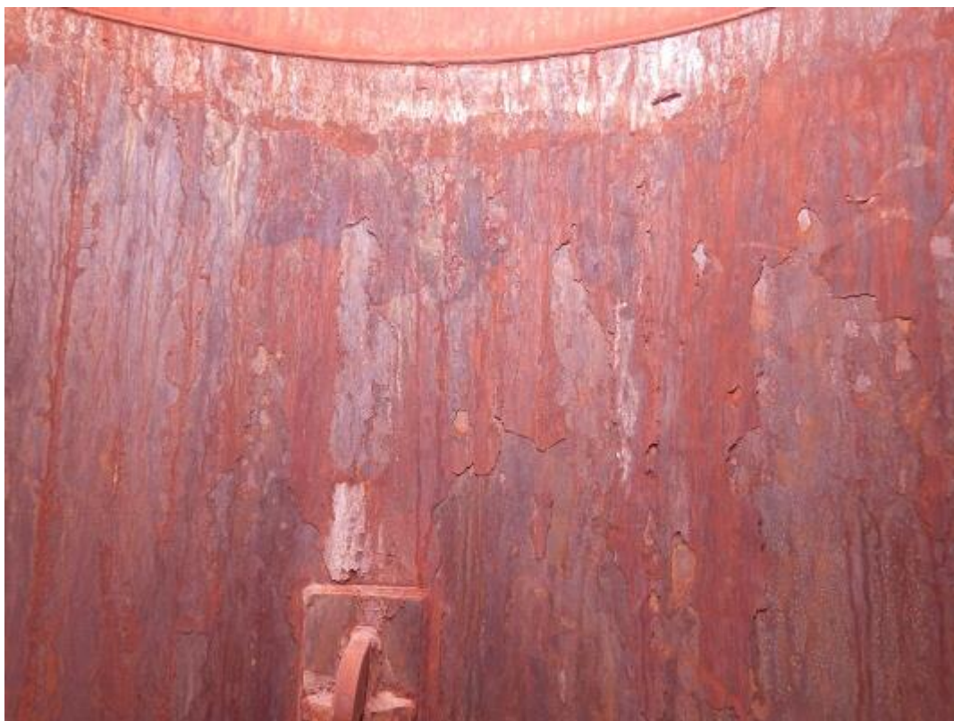
Obr. 27: Detail odlupujících se provozních a korozních úsad vnitřní ochranné vložky č.2 pod hlavou komína v cca +124,000m.
