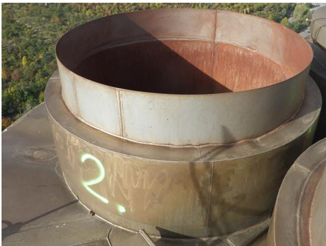
Obr. 26: Vnější oplechování vnitřní ochranné vložky č.2 v hlavě komína v +125,000m je bez závad.
