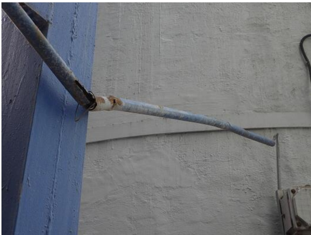
Obr. 2: Totální rozpad a absence kotvení ocelové chráničky elektroinstalace v patě komína na J straně.
