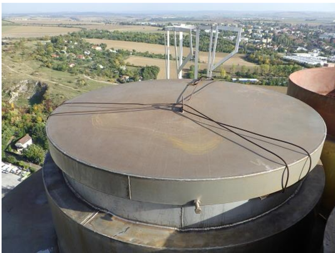
Obr. 24: Kryt nevyužívané ochranné vložky č.1 v +125,000m je bez závad.
