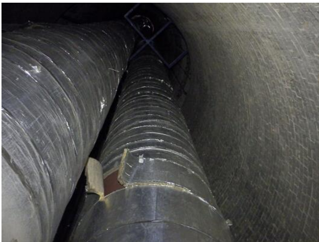
Obr. 51: Lokálně roztržená tepelná izolace ve spodní části vnitřní ochranné vložky č.3 v cca +10,000m.
