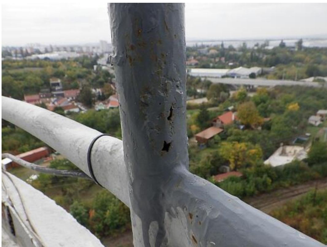
Obr. 8: Lokální díry v kotevní noze zábradlí a nedostatečně ukotvený kabel elektroinstalace na ochoze v +30,000m.
