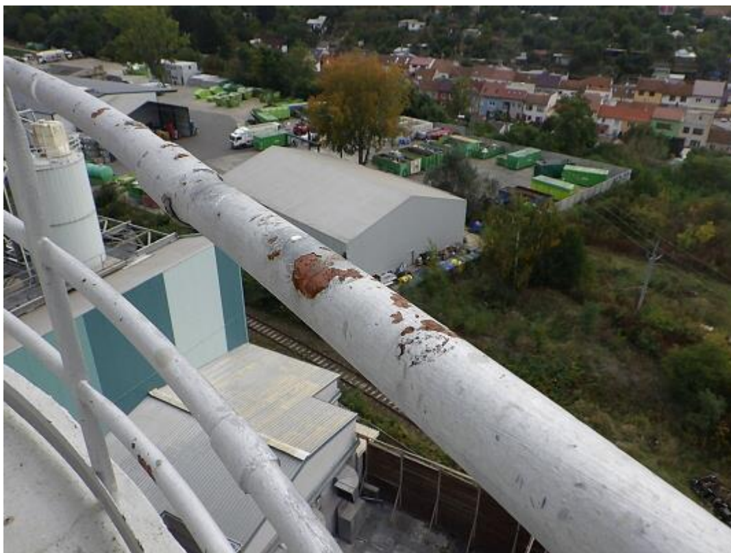
Obr. 9: Lokální koroze madel ocelového zábradlí ochozu v +30,000m.
