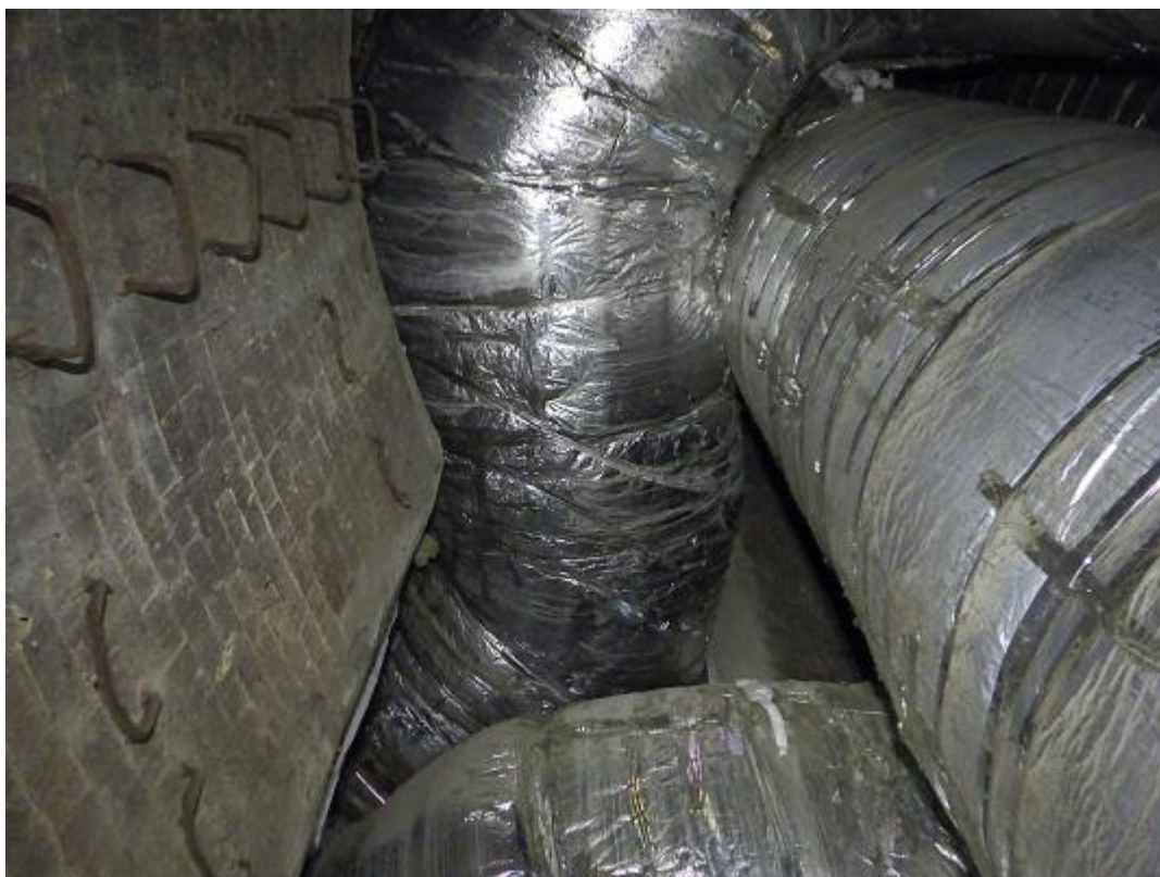
Obr. 49: Vnitřní ochranná vložka K1 a kouřovody k vložkám K2 a K3.
