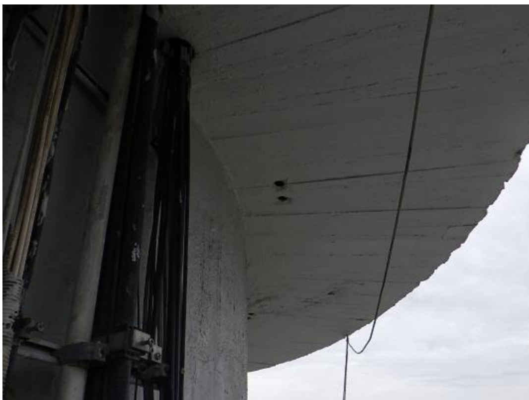
Obr. 6: Volně visící, neukotvený kabel elektroinstalace pod ochozem v +30,000m ze SZ strany komína.
