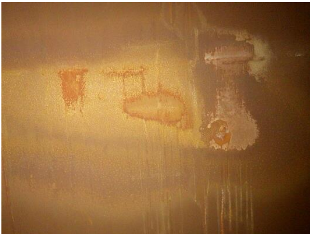
Obr. 31: Lokální poškození vnitřního povrchu vložky č.2 v cca +68,000m, vlivem svarů na vnějším povrchu. V budoucnu zde může dojít k proděravění!
