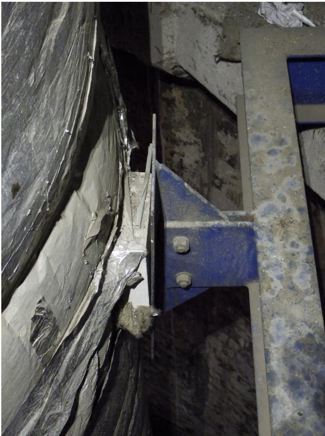
Obr. 57: Detail stabilizační konstrukce axiálního vedení vnitřní ochranné vložky č.2. Lokálně poškozená hliníková fólie tepelné izolace okolo stabilizační konstrukce.
