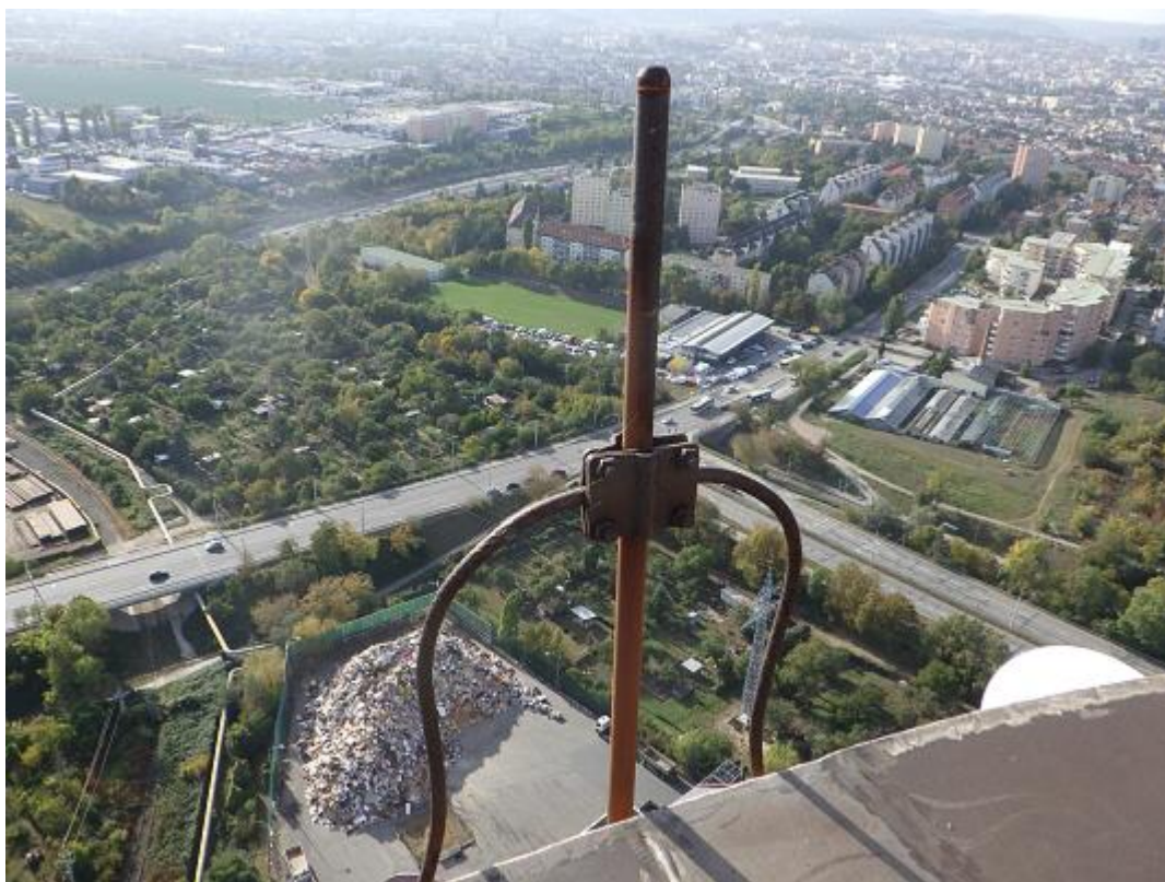
Obr. 23: Plošná až hloubková koroze jímací tyče, svorky a svodu v hlavě komína v +124,000m. Nevhodné (nevodivé) propojení! Propojit dle obr. 22.
