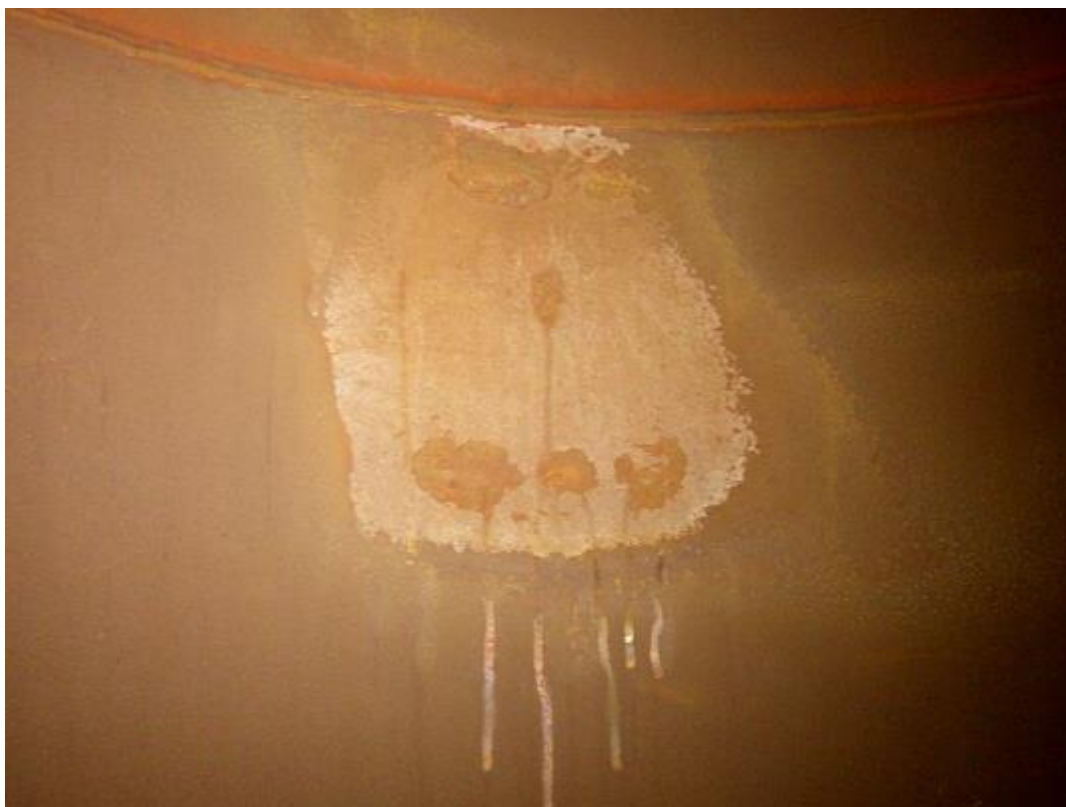
Obr. 33: Lokální poškození vnitřního povrchu vložky č.2 v cca +34,000m, vlivem svarů na vnějším povrchu. V budoucnu zde může dojít k proděravění!
