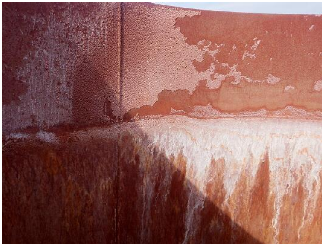
Obr. 37: Detail provozních sraženin a korozních úsad vnitřní ochranné vložky č.3 pod hlavou komína v +125,000m.
