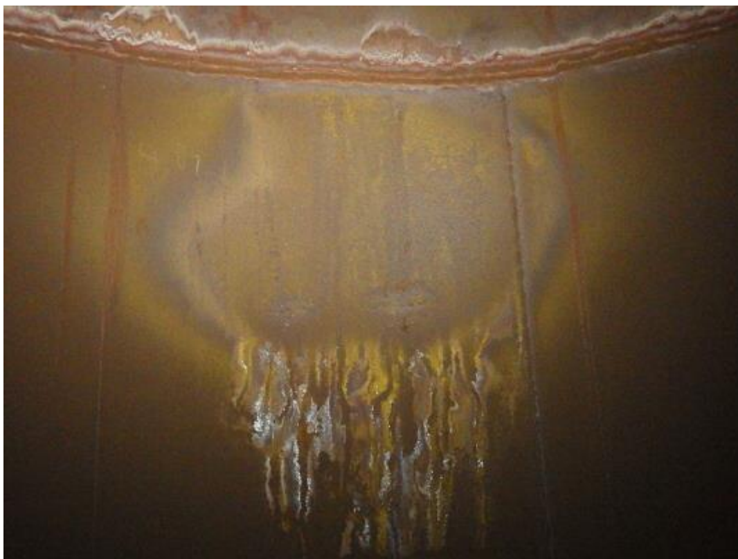
Obr. 43: Lokální poškození vnitřního povrchu vložky č.3 v cca +51,000m, vlivem svarů na vnějším povrchu. V budoucnu zde může dojít k proděravění.
