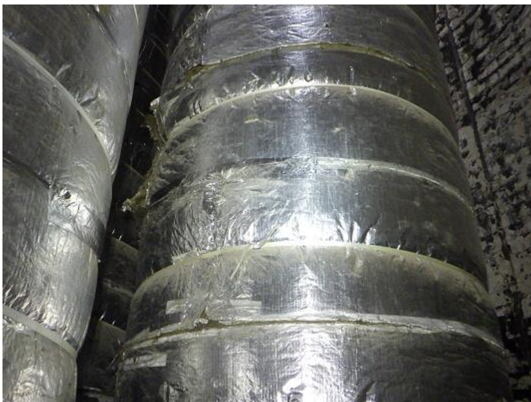
Obr. 53: Lokálně roztržená spojovací hliníková páska tepelné izolace vnitřní ochranné vložky č.2 v cca +25,000m.
