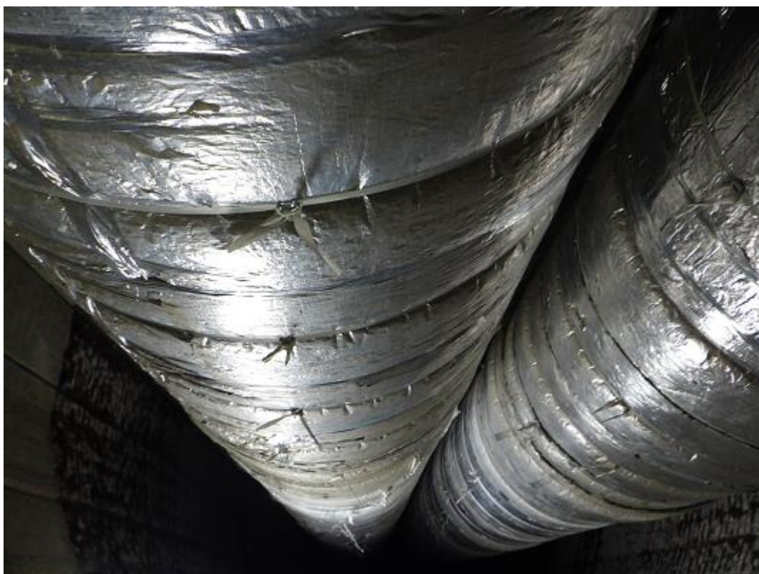
Obr. 55: Celkový pohled na meziprostor komína a na vložky č.1 (vlevo) a č.2 (vpravo) od cca +35,000m. Tepelná izolace obou vložek je bez závad.
