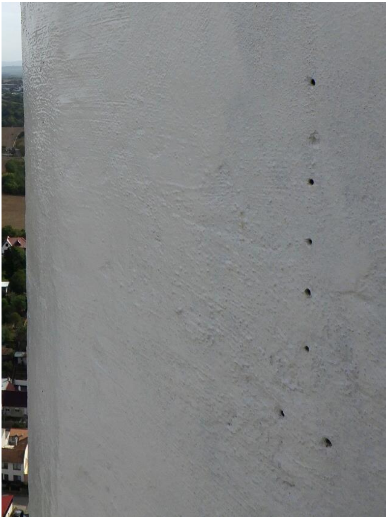
Obr. 16: Nezatmelené (nesanované) díry v žlb. dříku komína v cca +100,000m ze S strany.
