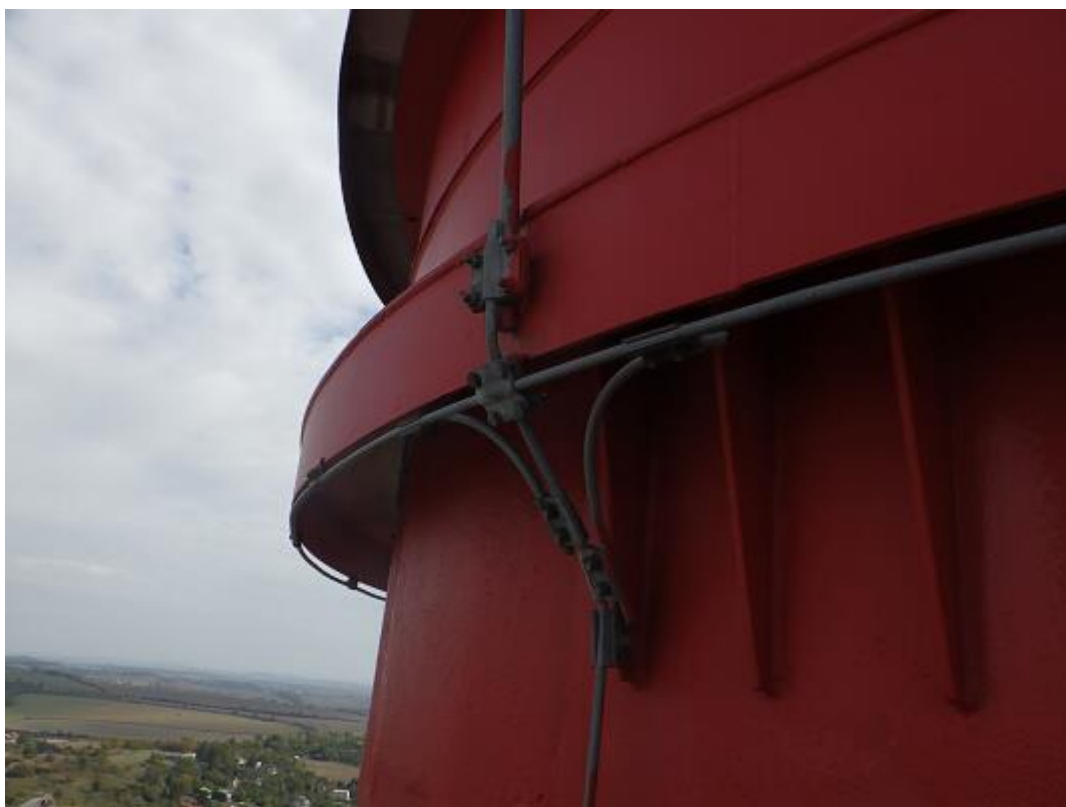
Obr. 22: Okružní vodivé propojení jímací soustavy a horního ocelového dílu komína pod hlavou se svislým svodem v +124,000m.
