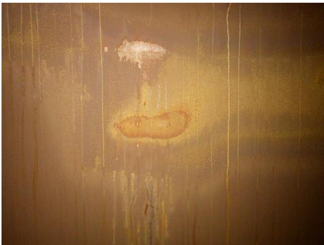
Obr. 30: Lokální poškození vnitřního povrchu vložky č.2 v cca +68,000m, vlivem svarů na vnějším povrchu. V budoucnu zde může dojít k proděravění!
